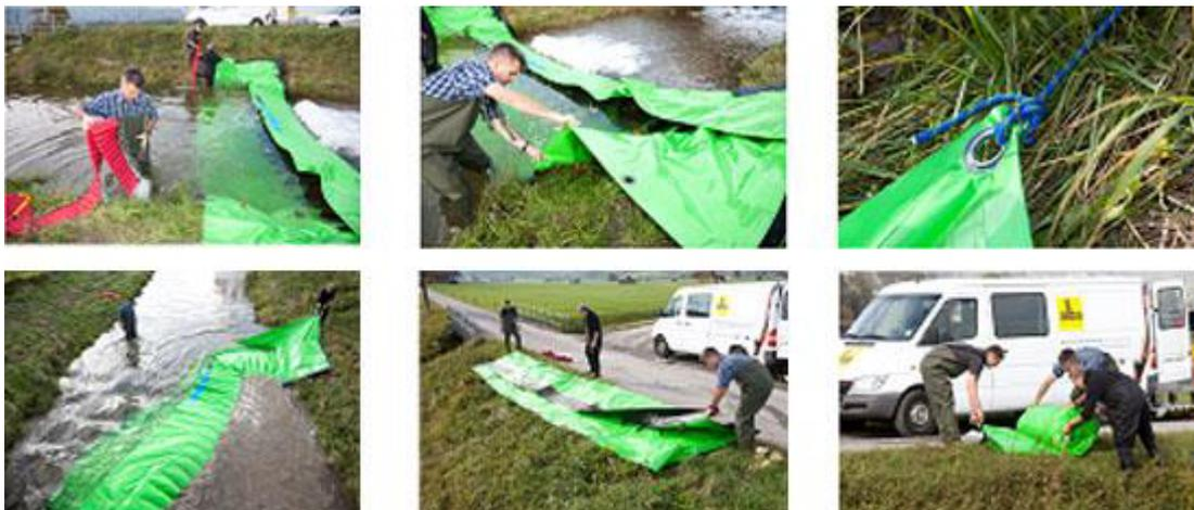
Nachdem die Rollandsäcke, respektive die Steine, wieder entfernt wurden, wird der untere Klappsperrschenkel der Sperre angehoben. Dabei wird die Sperre aufgrund des Wasserdrucks automatisch weggezogen. Da die Wassersperre auf einer Seite mit einem Seil befestigt wird, kann sie nicht weggeschwemmt werden. Jetzt zieht man die Sperre an Land und rollt sie wieder ein. Auf diese Weise bleibt sie bis zum nächsten Einsatz platzsparend verstaut.
